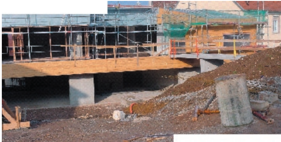
Construction du Multi-Accueils à Dettwiller
